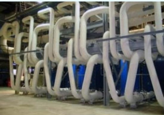
Теплометт дает возможность визуального контроля и быстрого доступа к запорной арматуре
